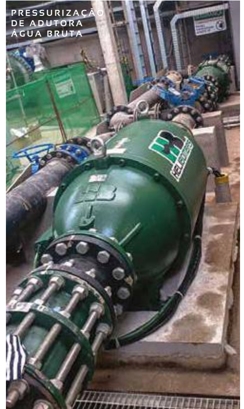
BOOSTER PARALELO ÁGUA TRATADA
